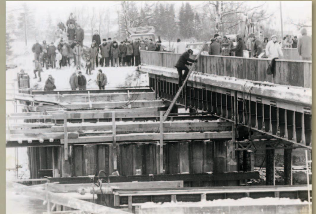
Für den Neubau der Illerbrücke in Wiblingen musste die alte 780 Tonnen schwere und 75 Meter lange Brücke 12 Meter flussaufwärts verschoben werden.
