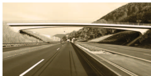
Abb. 3 – Feldwegbrücke über die A8 bei Gruibingen
