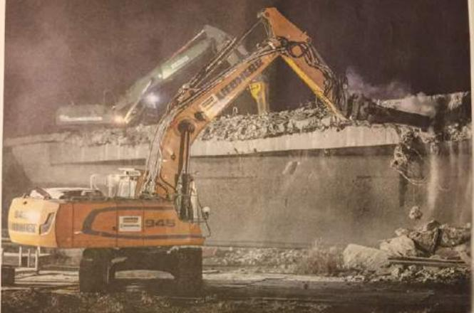
Volle Bagger-Power gegen den Stahlbeton von 1937. Am Wochenende wurden zwei alte Brücken über die A 8 zerlegt. Foto: Volkmr/Könnig
