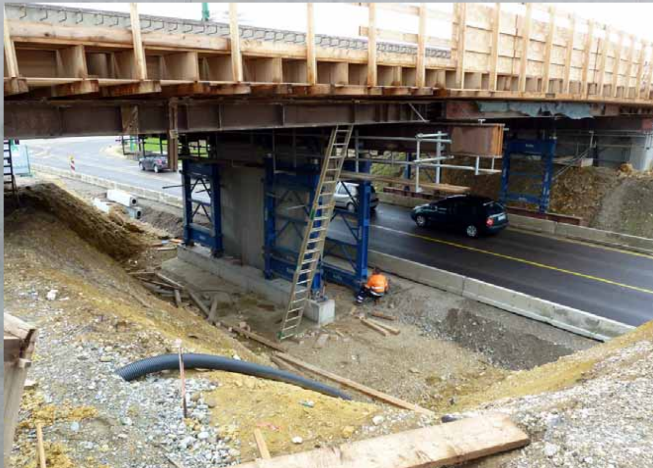
Umbau Fischerkreuzung B311
