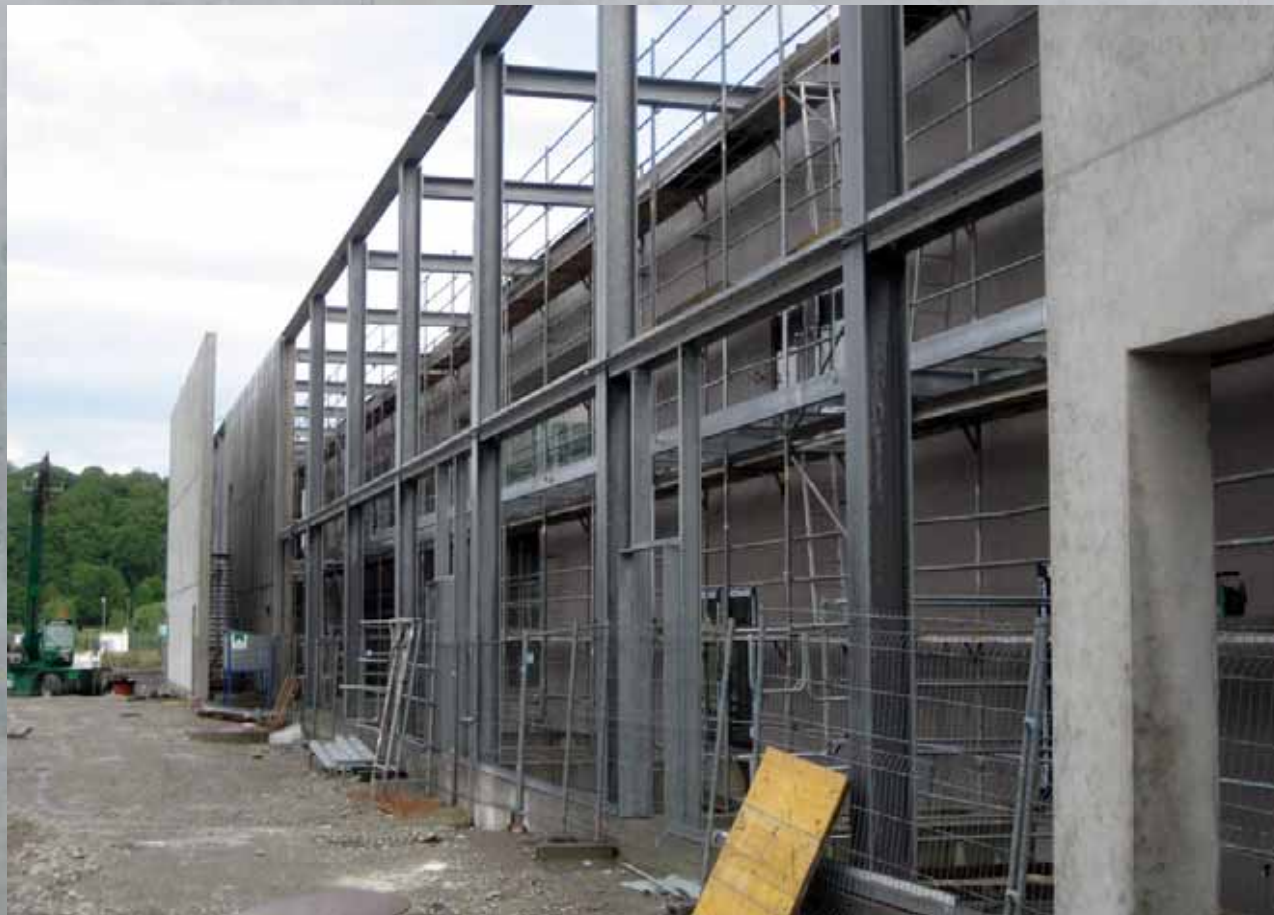
Boehringer Ingelheim Laborgebäude G155
