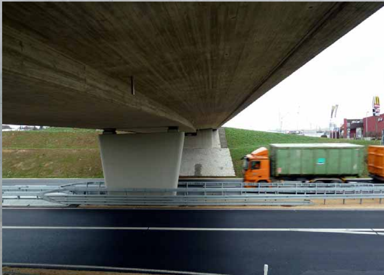
Umbau Fischerkreuzung B311
