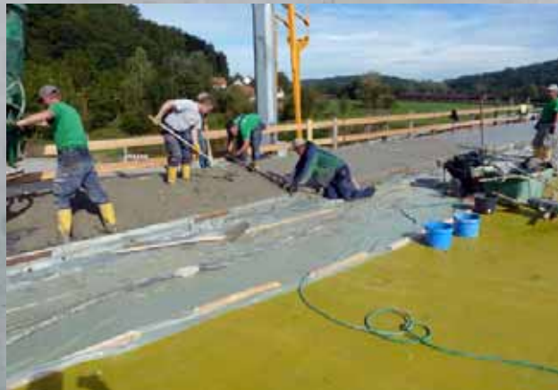
Brücken 3-streifiger Ausbau B30
