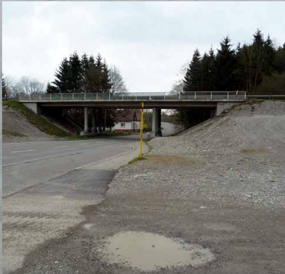
Brücken 3-streifiger Ausbau B30
