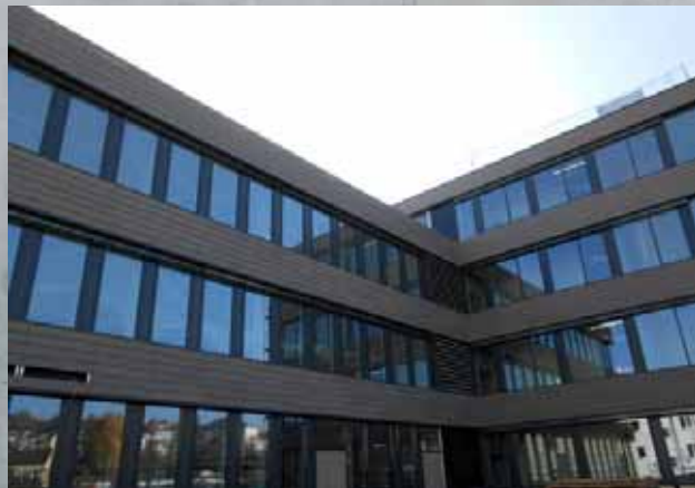
Neubau Verwaltungsgebäude SWU
