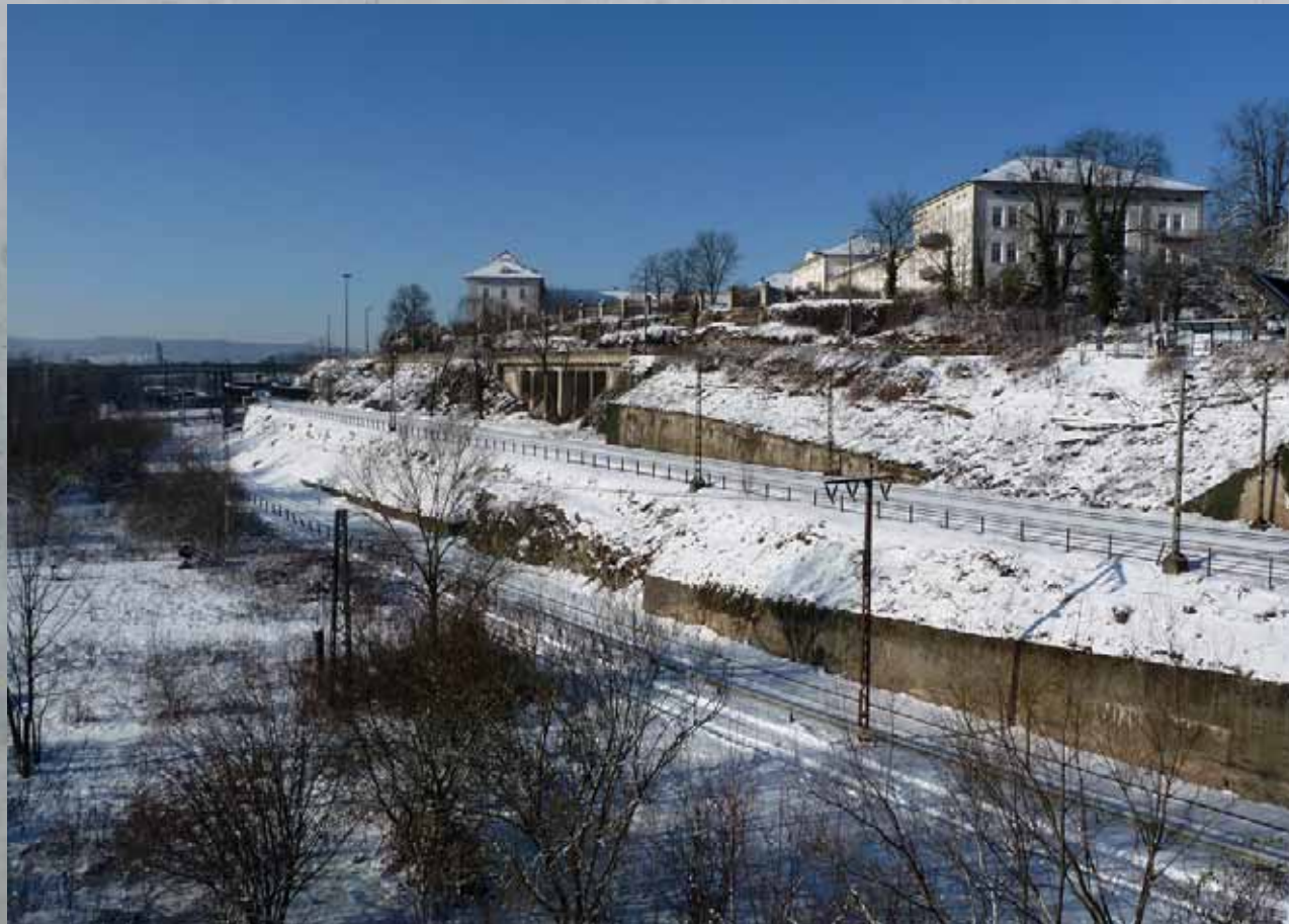
Umbau Bahnhof Ulm, Nordkopf im Zuge der Neubaustrecke Stuttgart-Ulm
