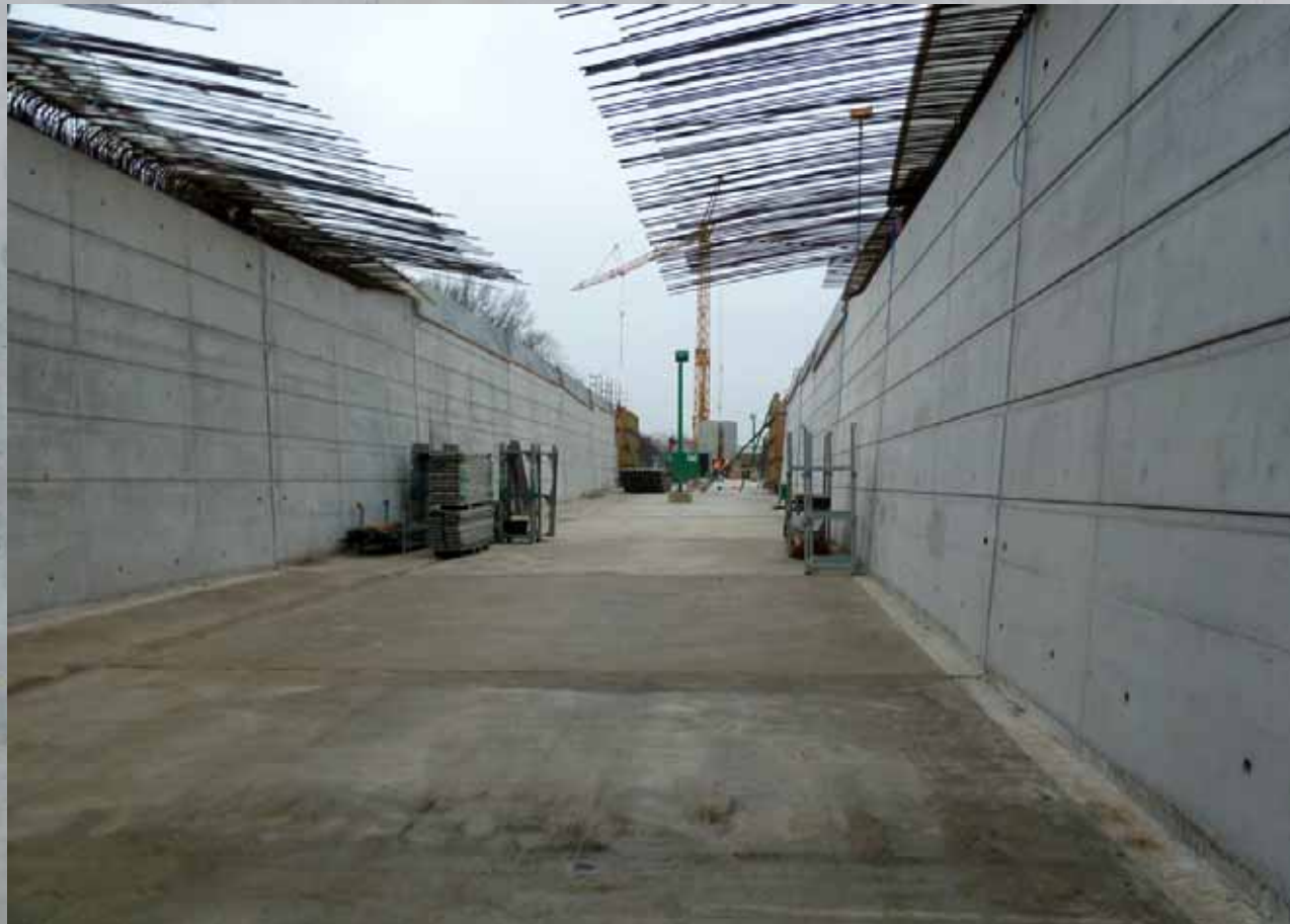
Umbau Kreuzung B10 Europastrasse / Reuttierstrasse
