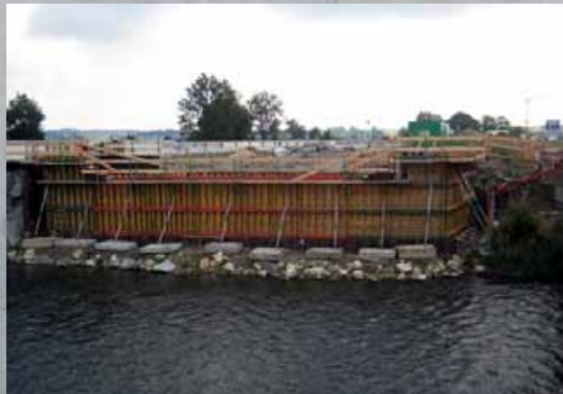
Neubau dreier Brücken der A8 . BW 123 Mindelbrücke
