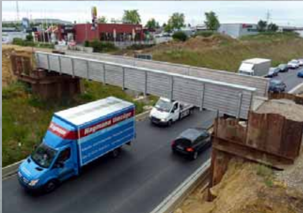
Umbau Fischerkreuzung B311
