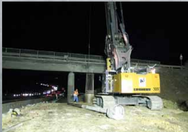
Neubau dreier Brücken der A8 . BW 129
