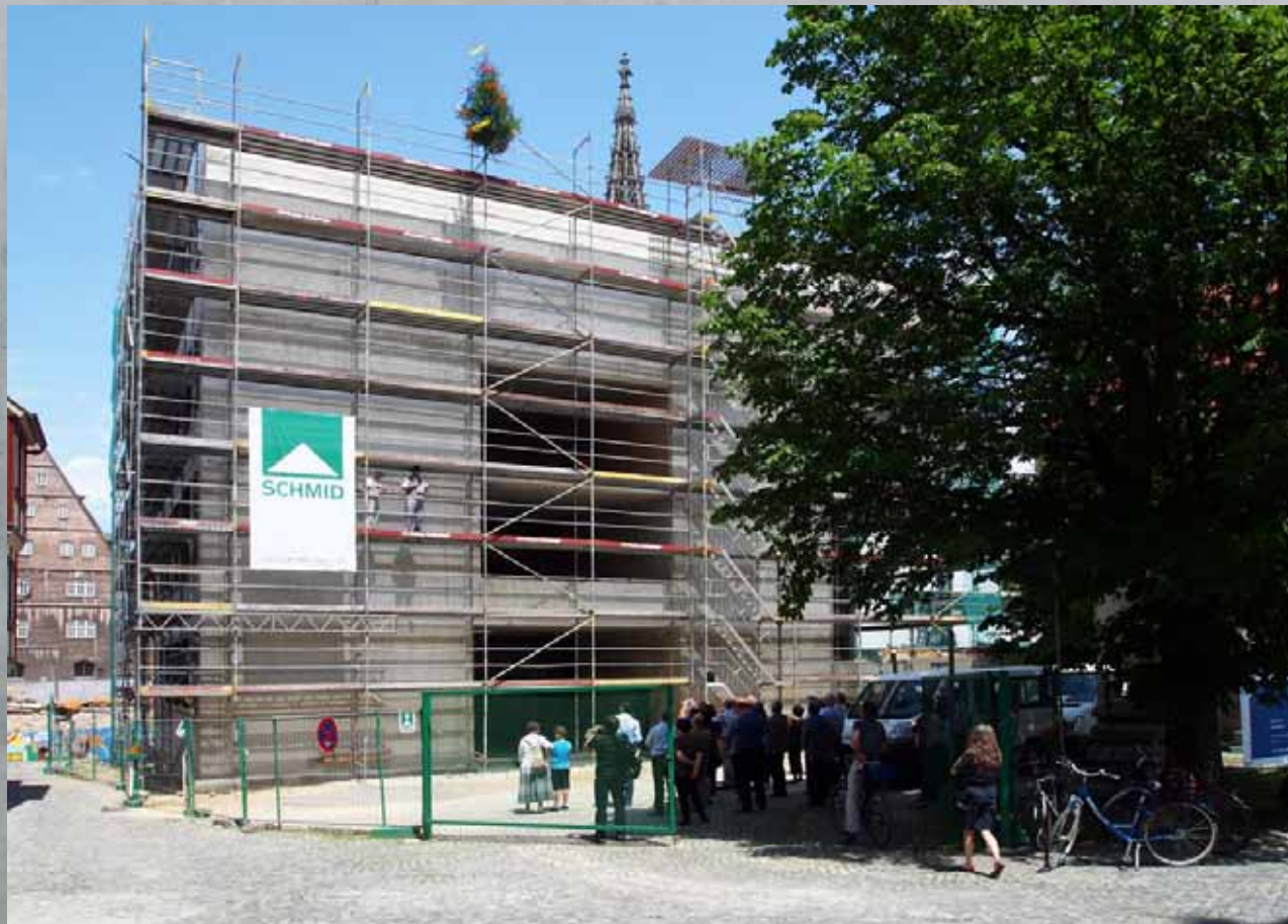
Neubau Gemeindezentrum mit Synagoge am Weinhof
