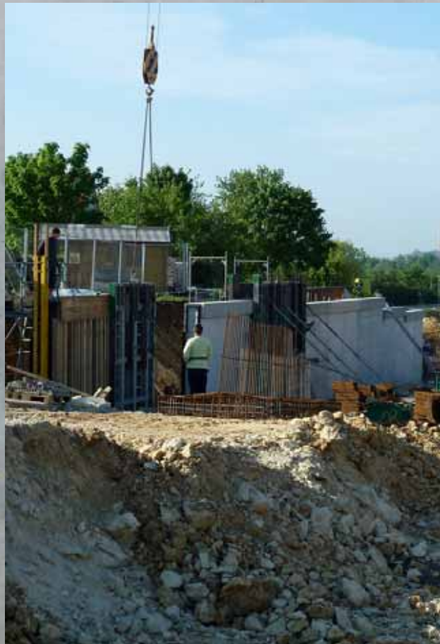
Umbau Fischerkreuzung B311
