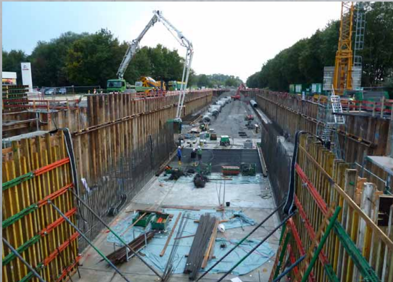
Umbau Kreuzung B10 Europastrasse / Reuttierstrasse
