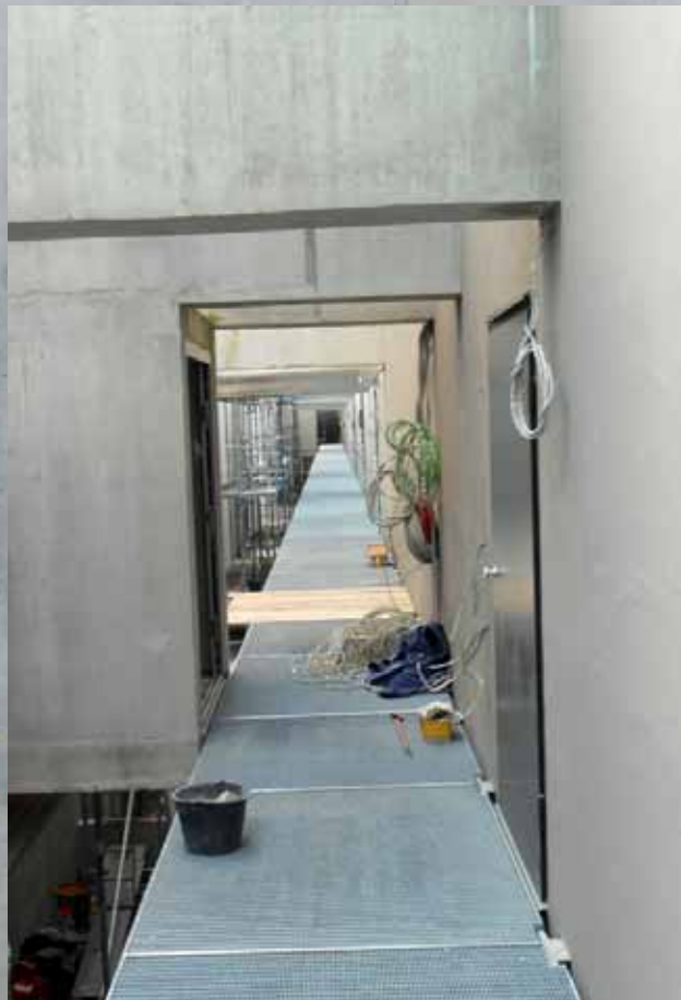
Boehringer Ingelheim Laborgebäude G155
