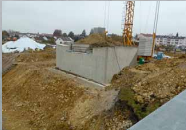
Umbau Fischerkreuzung B311
