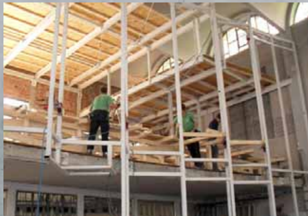
Umbau und Sanierung Rosenbergkirche
