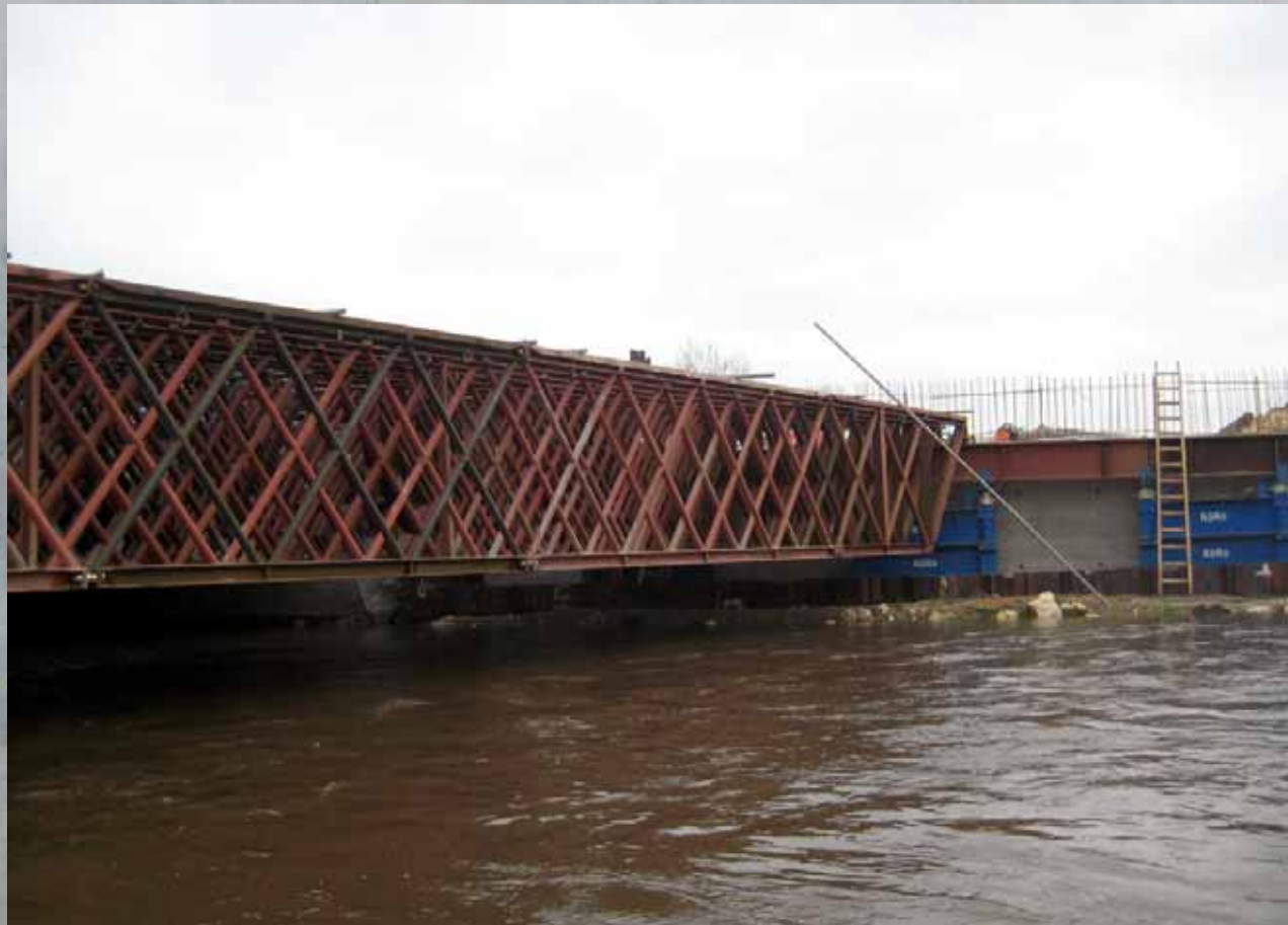
Neubau dreier Brücken der A8 . BW 123 Mindelbrücke
