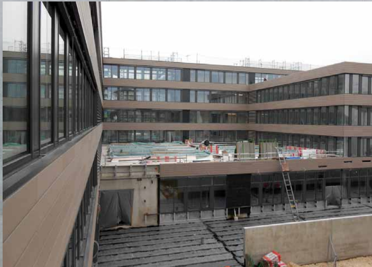
Neubau Verwaltungsgebäude SWU
