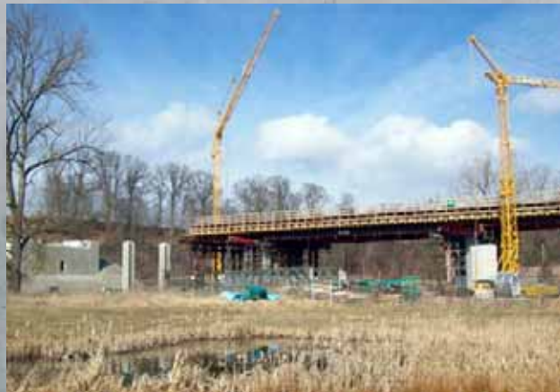
Brücke BW5 Nordwestumfahrung Biberach K7532
