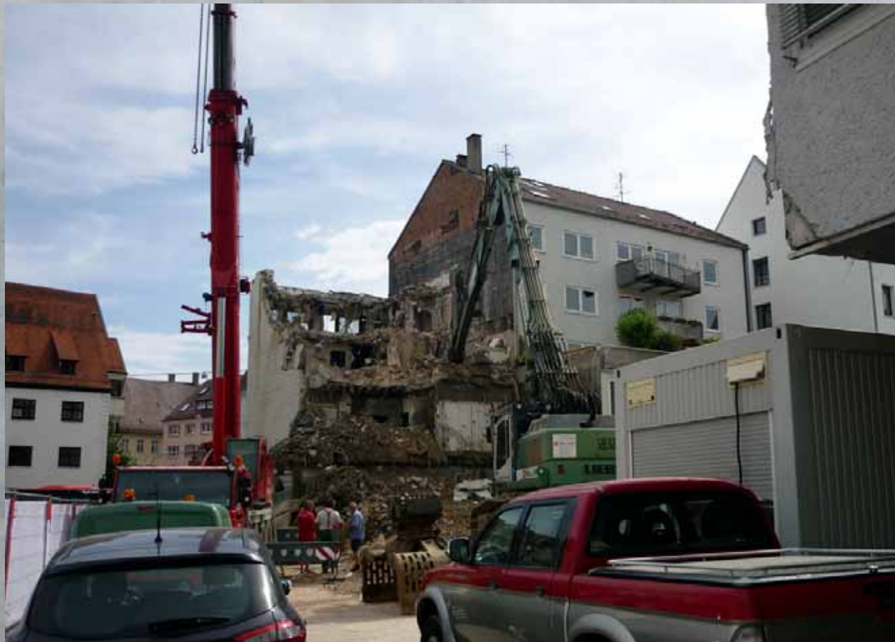
Geschäftshaus Activ Corner Frauenstrasse
