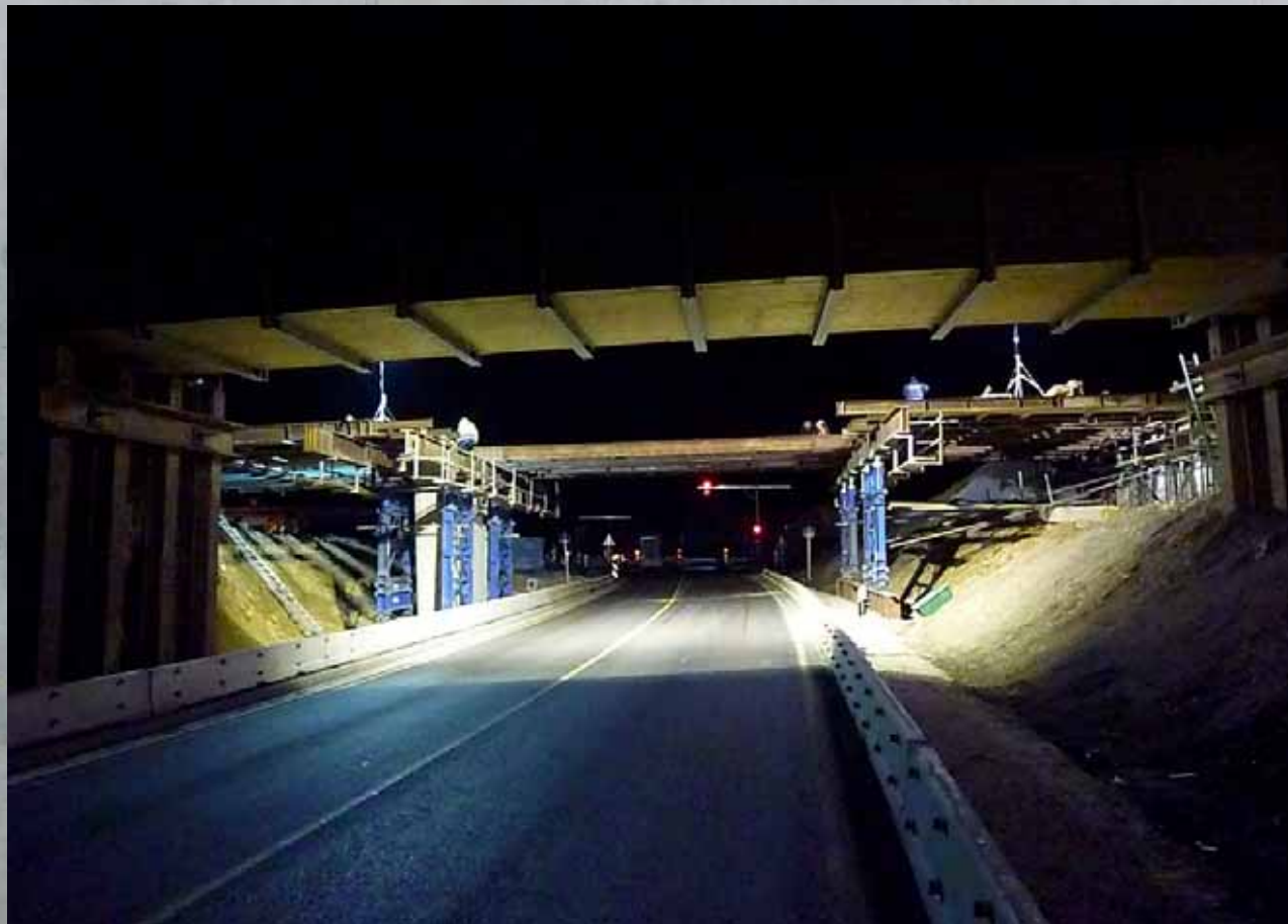
Umbau Fischerkreuzung B311
