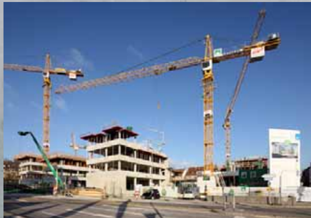
Neubau Verwaltungsgebäude SWU
