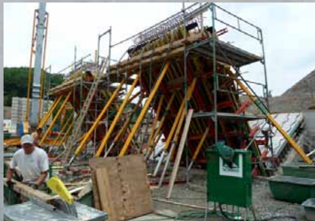
Brücken 3-streifiger Ausbau B30
