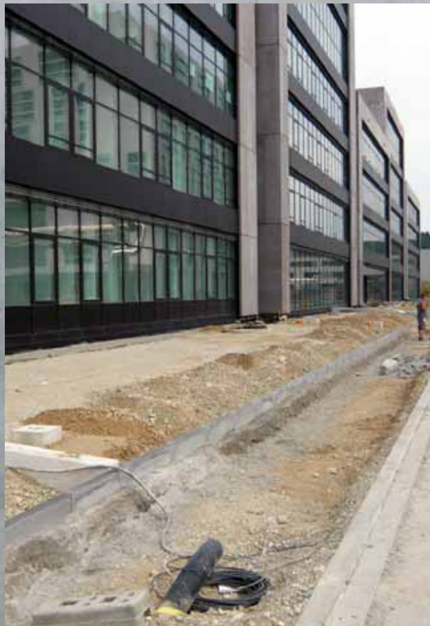
Boehringer Ingelheim Laborgebäude G155
