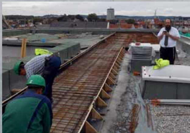
Neubau Gemeindezentrum mit Synagoge am Weinhof
