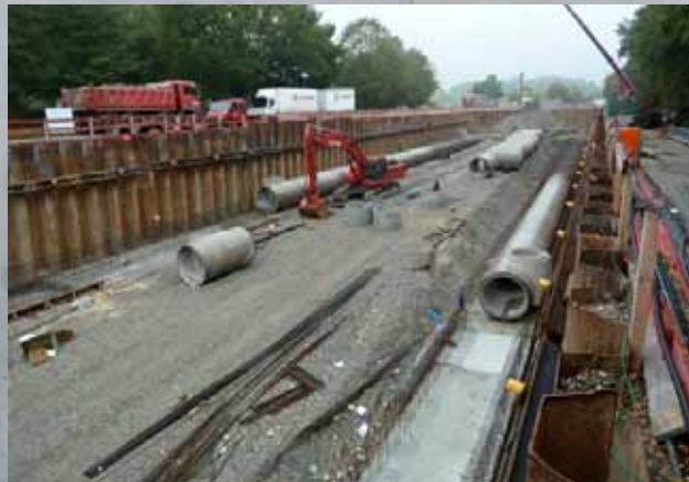
Umbau Kreuzung B10 Europastrasse / Reuttierstrasse
