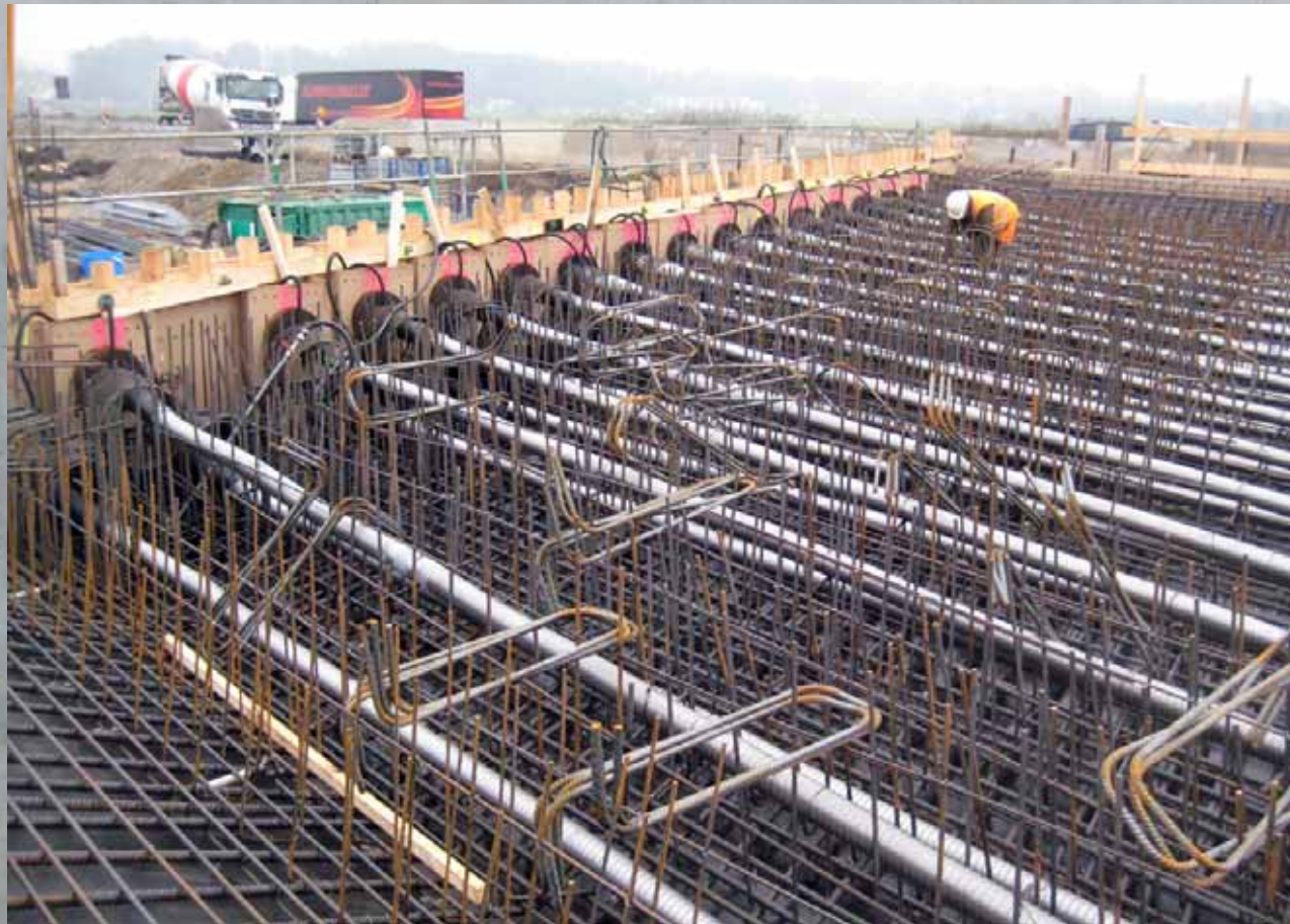
Neubau dreier Brücken der A8 . BW 123 Mindelbrücke
