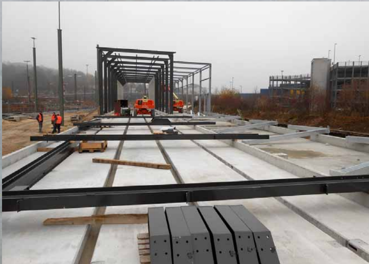
DB ARA Waschhalle und Betriebsgebäude
