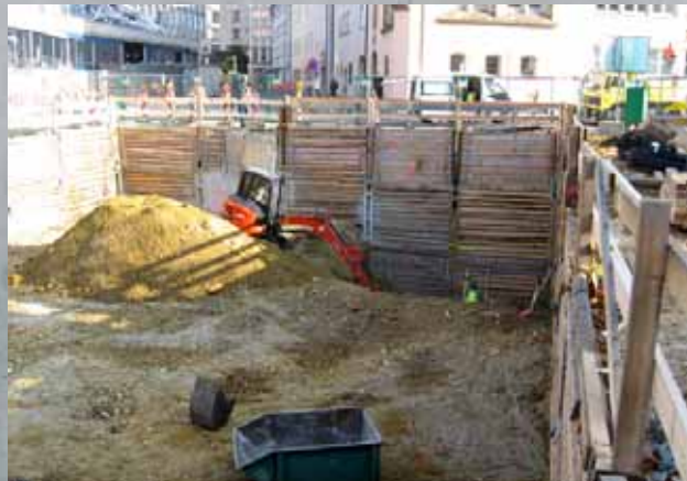
Neubau Gemeindezentrum mit Synagoge am Weinhof
