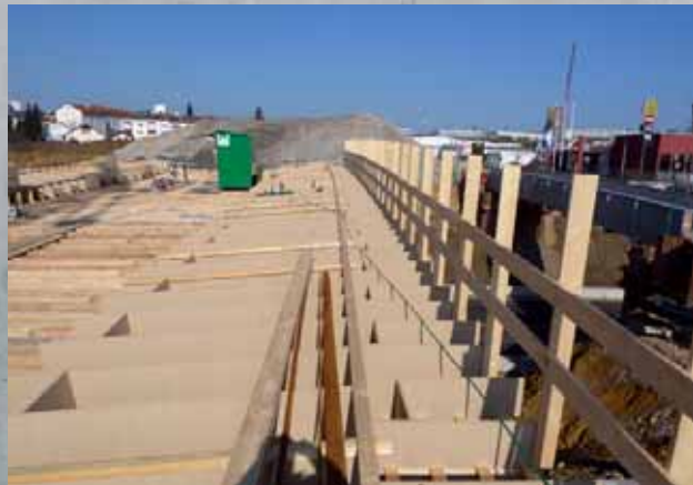
Umbau Fischerkreuzung B311
