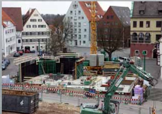
Neubau Gemeindezentrum mit Synagoge am Weinhof
