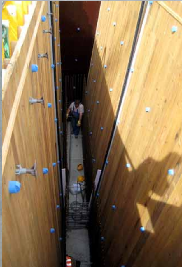
Neubau dreier Brücken der A8 . BW 129
