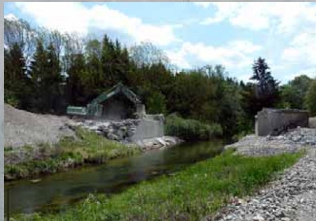
Brücken 3-streifiger Ausbau B30
