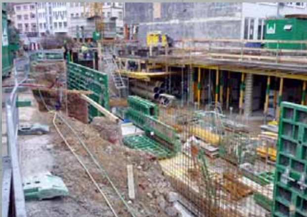
Geschäftshaus Activ Corner Frauenstrasse
