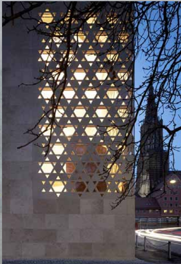
Neubau Gemeindezentrum mit Synagoge am Weinhof
