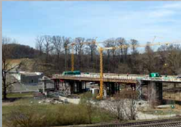
Brücke BW5 Nordwestumfahrung Biberach K7532
