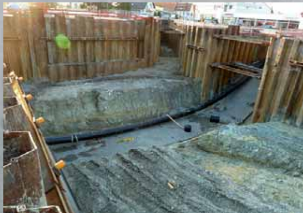
Umbau Kreuzung B10 Europastrasse / Reuttierstrasse
