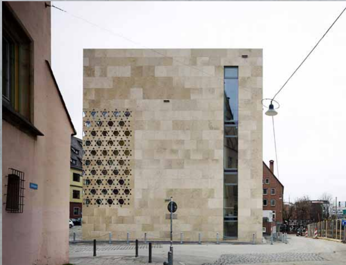
Neubau Gemeindezentrum mit Synagoge am Weinhof
