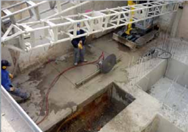
Geschäftshaus Activ Corner Frauenstrasse
