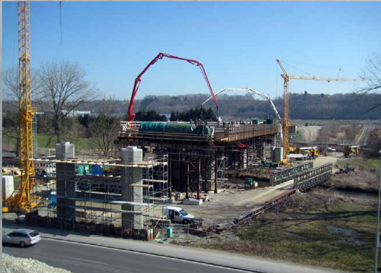
Brücke BW5 Nordwestumfahrung Biberach K7532
