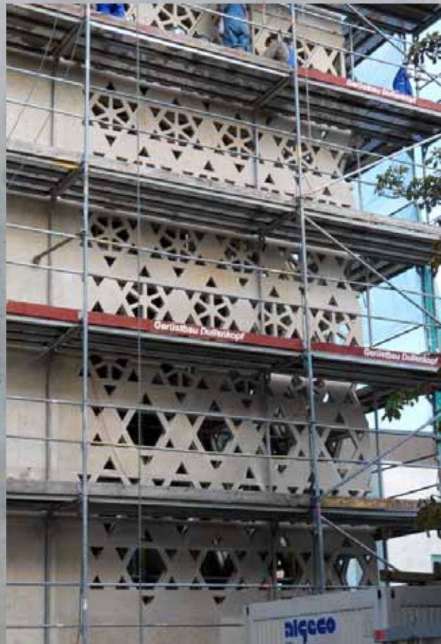
Neubau Gemeindezentrum mit Synagoge am Weinhof
