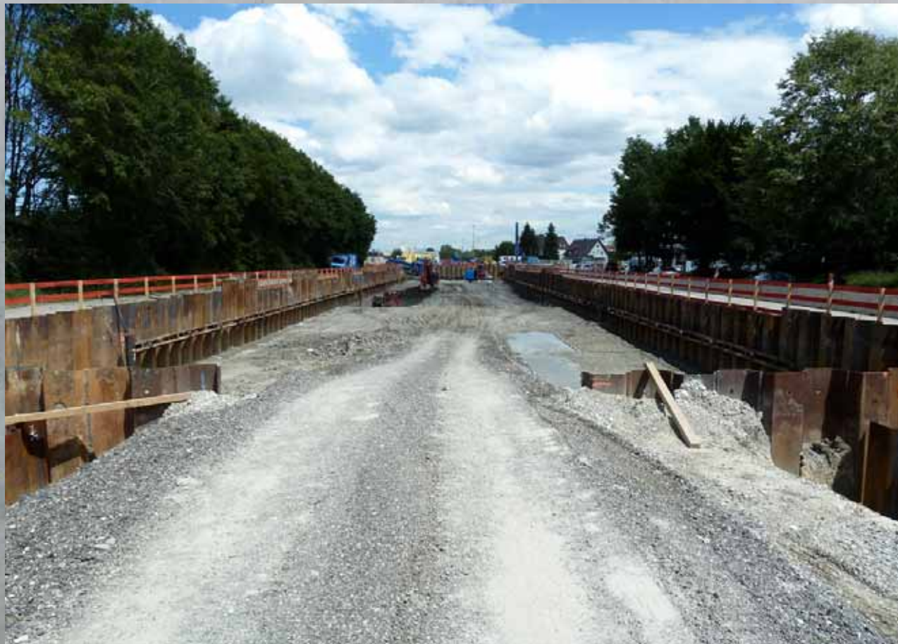
Umbau Kreuzung B10 Europastrasse / Reuttierstrasse
