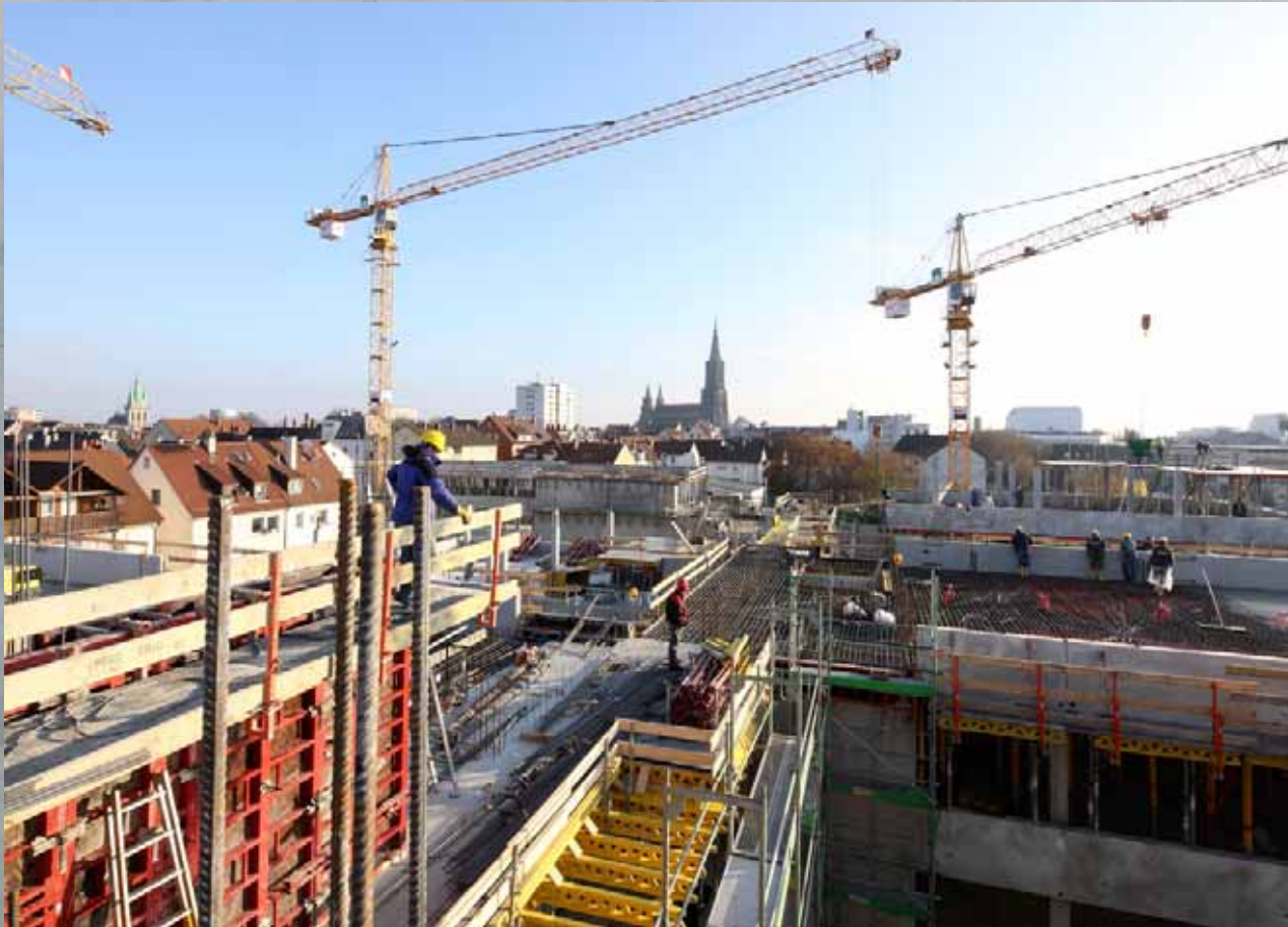
Neubau Verwaltungsgebäude SWU
