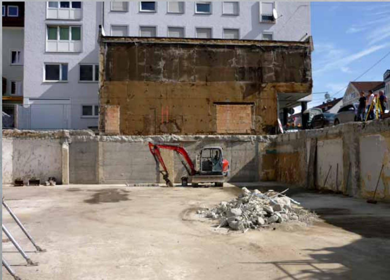
Geschäftshaus Activ Corner Frauenstrasse
