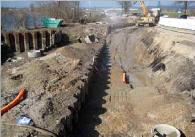
Neubau dreier Brücken der A8 . BW 122a Erlenbachbrücke
